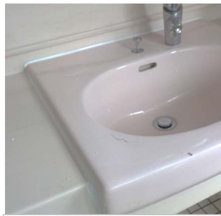
施工後 女子トイレ手洗洗面台
