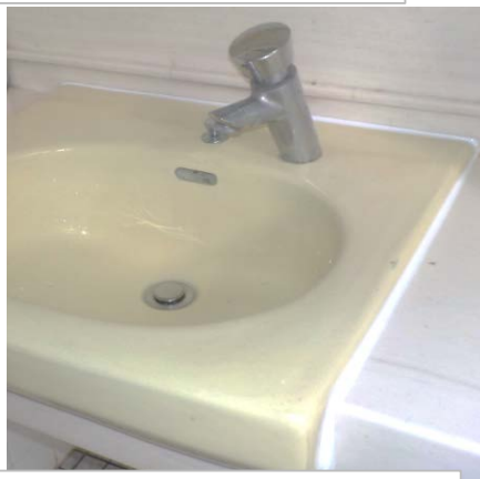
施工後 男子トイレ手洗洗面台
